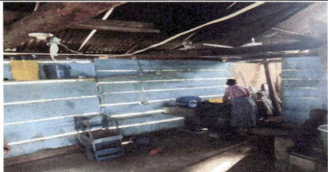
Foto 7: vista interior de cocina con muro sobre puesto de madea y lamina mal puesta
