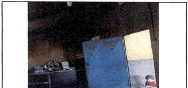
Foto 12: Puerta en mal estado con marcas de corrosion y con agujeros.
