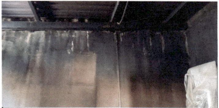
Foto 10: Muro totalmente dañado y con mucha humedad
